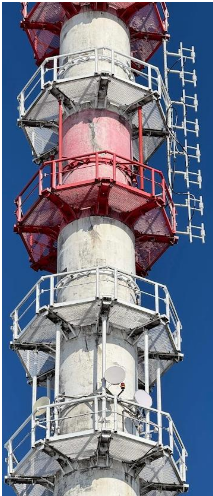
Na východní straně tubusu přibylo osm pater VHF dipólů pro digitalní rozhlas / DAB /
