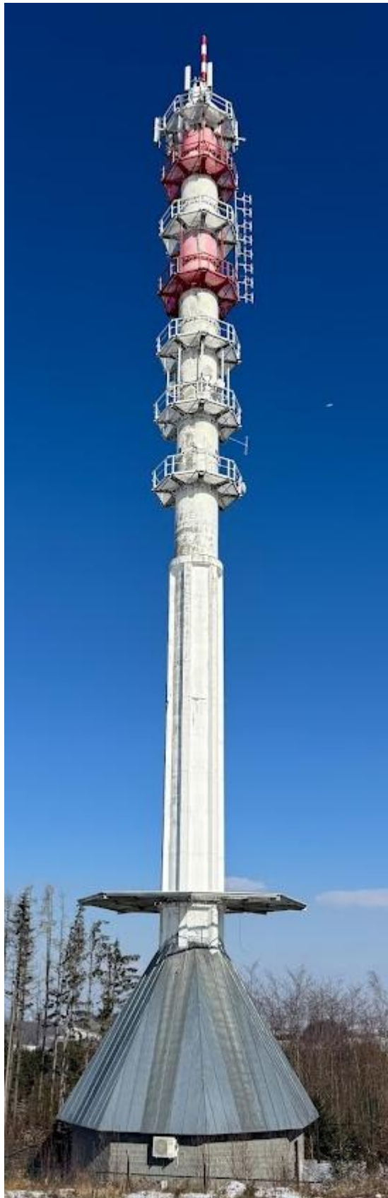
Na východní straně tubusu přibylo osm pater VHF dipólů pro digitalní rozhlas / DAB /
